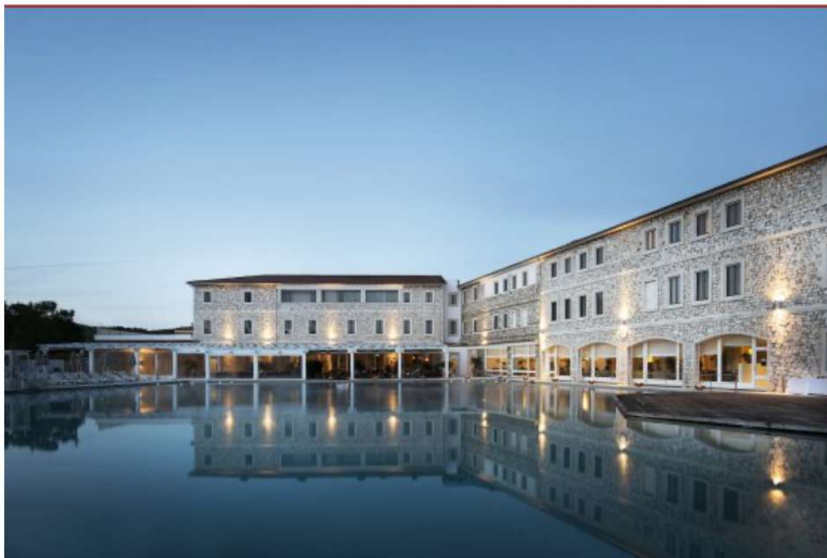
Particolare della struttura termale del resort
